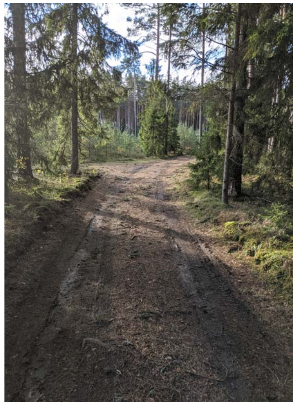
Foto 3 ja 4. Piio-Mustjala tee pk 1+20, roopad ja märk koht ja tee pk 4+00 (10.2023)
